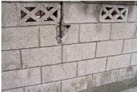
塀に大きなひび割れが生じている
