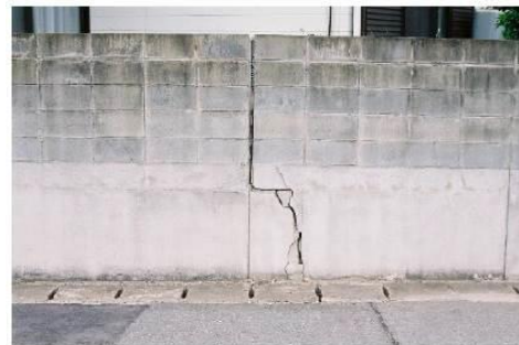
塀に大きなひび割れが生じている
