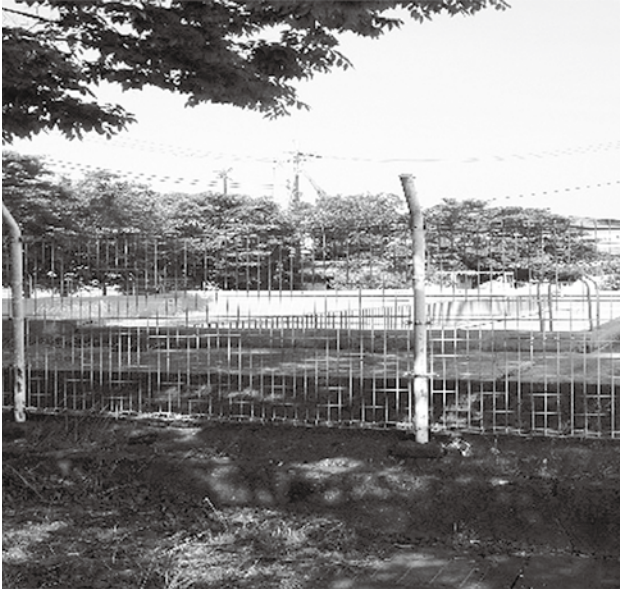
利用していない東小学校プール
