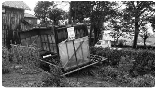
台風21号による被害
