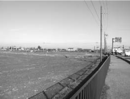
造成工事が始まった交流村（金屋）
