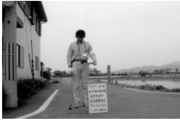
漏水調査風景
