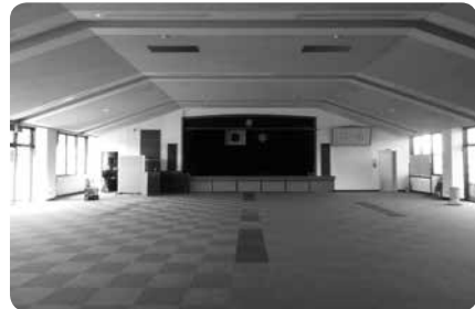
空調設備を予定している甲良町公民館
