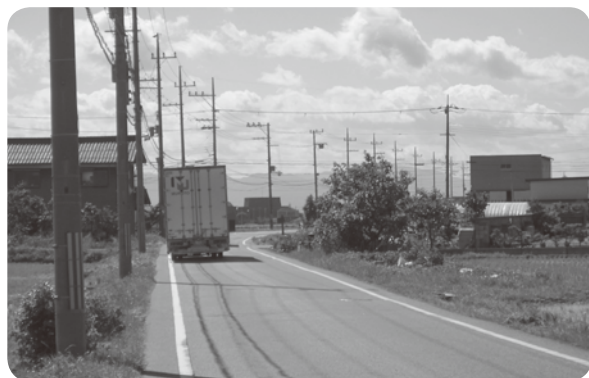
センターラインがない町道池寺下之郷線
