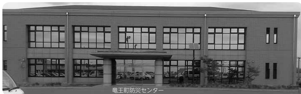
竜王町防災センター
