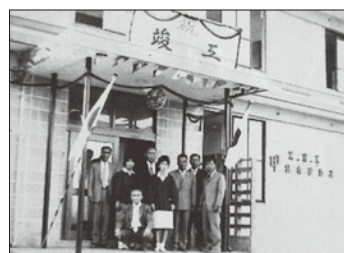
有線本部(役場南側ブロック建て)
