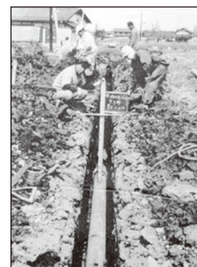
下之郷付近敷設作業
