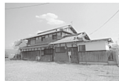
No. ② 建物裏面
