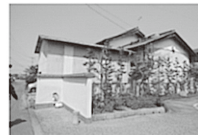
No. ② 建物側面
