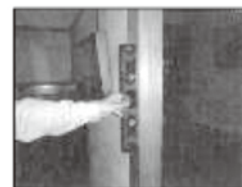
水平器による 柱の傾きの計測
