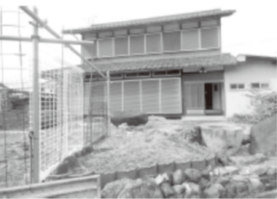
No. ① 建物正面
