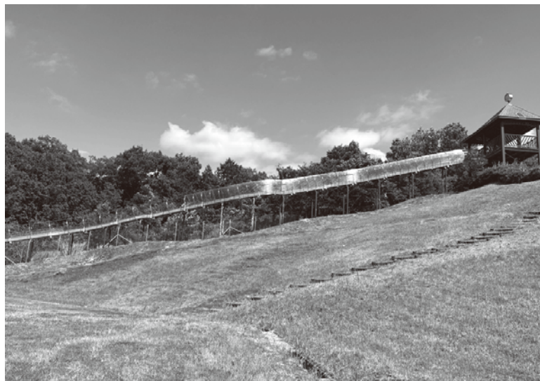
改修工事が完了したローラーすべり台
