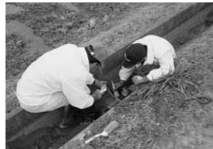
これで大丈夫！農業組合で用水路の目地補修
