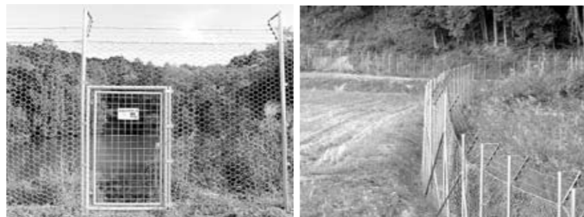
平成22年度に整備された正楽寺獣害フェンス
