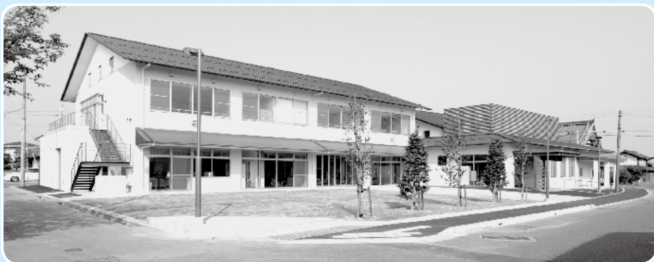
呉竹地域総合センター 全館写真
