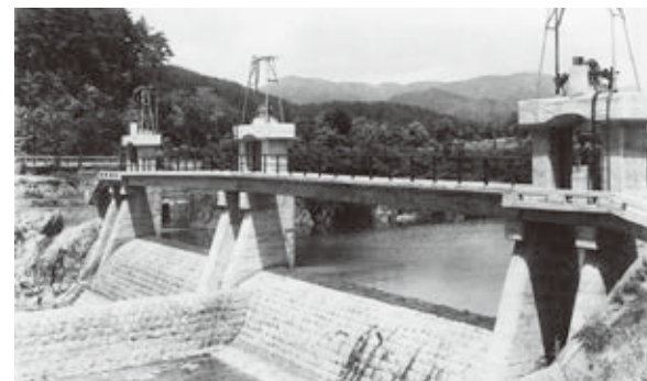
△金屋頭首工 高さ4.5mの割石張りコンクリート造りの固定式分水堰。昭和10年竣工。
