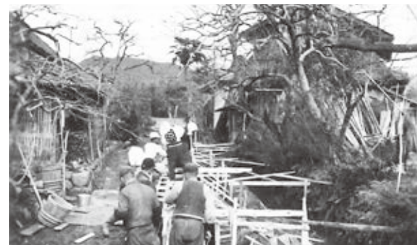
△上島田川改修工事（昭和28年頃） 水路改修工事の様子。上島田川の水系は、金屋から池寺方面に流れています。
