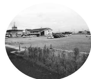
一部整備される町役場東側駐車場
