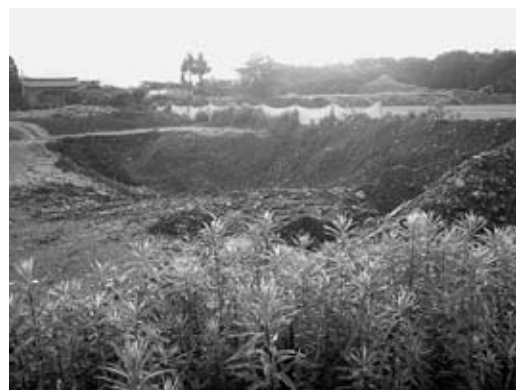
小川原掘起現場
