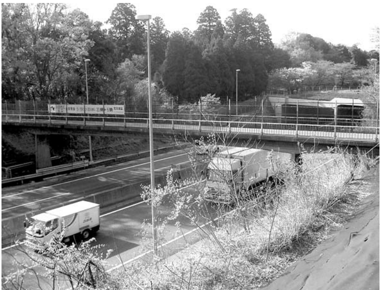
名神高速道路西明寺橋
