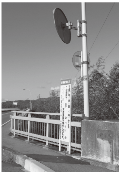
死亡事故があった犬上大橋 (情報提供を求めている)
