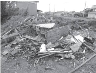
倒壊した空き家
